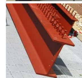
Stahlprofil der Verbundträger mit aufgeschweißten Kopfbolzendübeln
