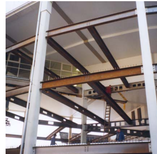
Montage der Stahlträger in Phase 3
