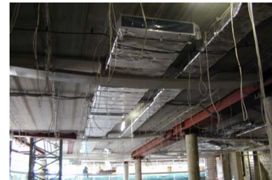
Bild 3.3 Installation der TGA- Leitungen
