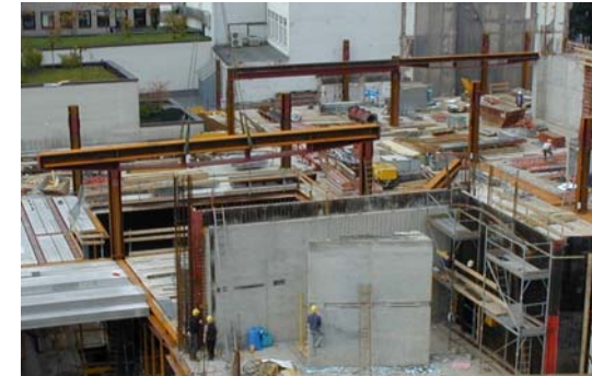
Bild 3.1 Montage der DRAHEIM-Träger
