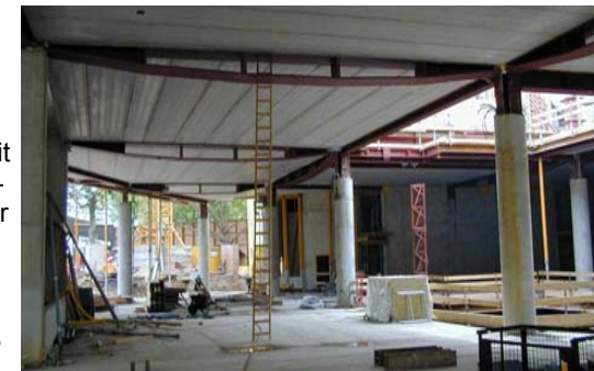
Bild 3.2 Deckenuntersicht im Rohbau
