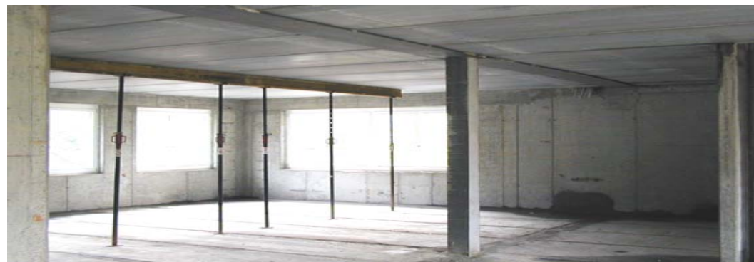
Stahlflachdecke im Rohbau
